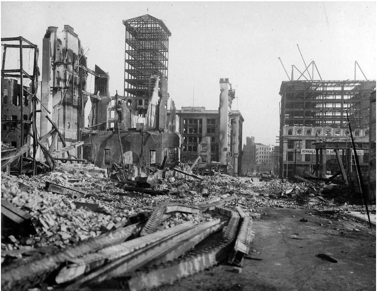
Рис.2. Последствия землетрясений в городе
