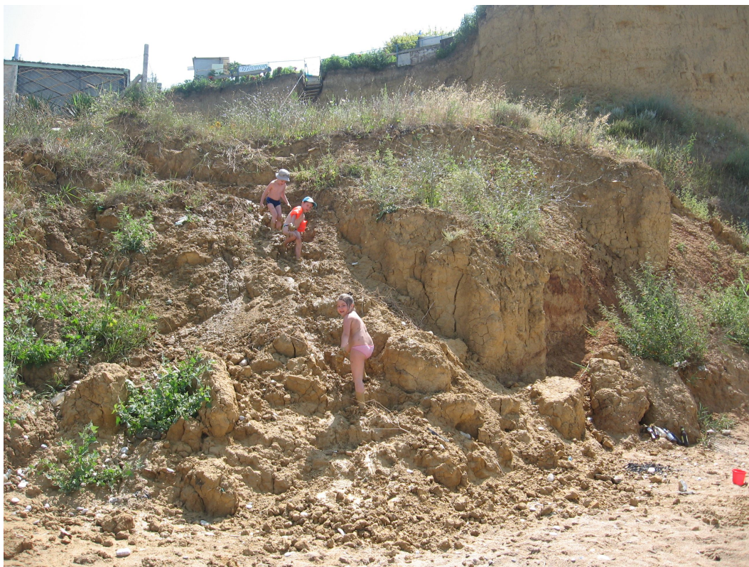
Рис. 5. Блоковый оползень. Крым, Любимовка.
