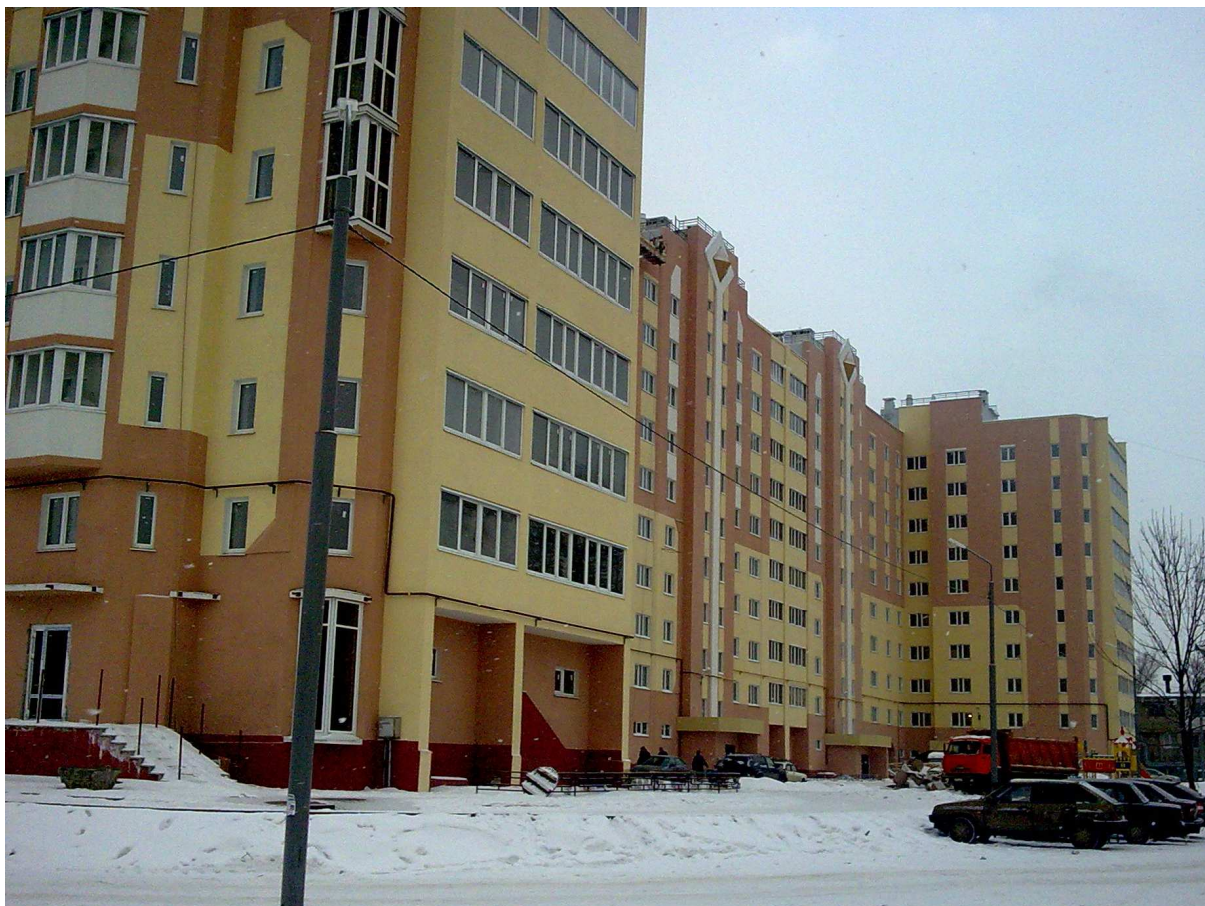
Рисунок 2. Общий вид жилого дома по ул. Скороходова в г. Липецке.
