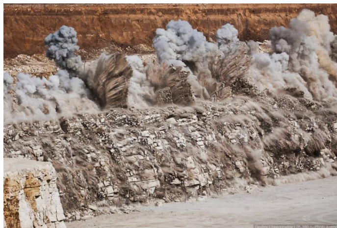
Рис.1 Буро-взрывные работы, проводимые на Ситовском карьере
