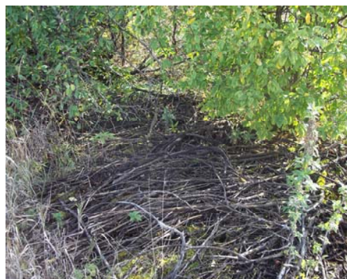
Рисунок 4. Отсутствие необходимых сооружений над водозаборными скважинами.
