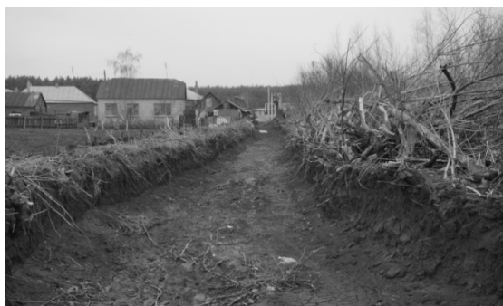
Рис. 2. Водоотводящая канава в п. Воля
