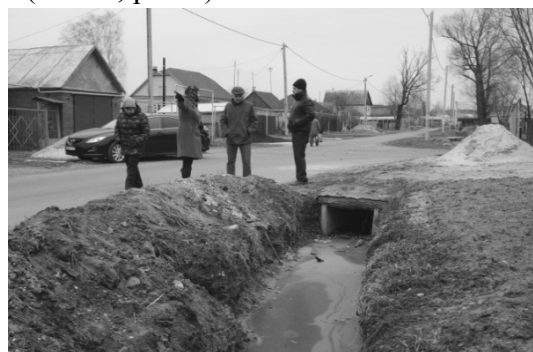
Рис. 3 Водоотводящая канава в п. Шуберское
