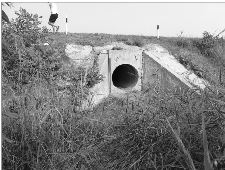
Рис. 2. Водовыпускная труба автодороги Воронеж – Луганск
