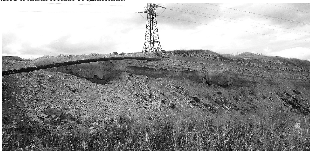
Рис. Обваливание и осыпание западной стенки карьера над трубопроводом
