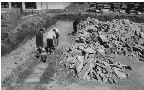
Укрепление грунтов основание короткими грунтоцементными сваями
