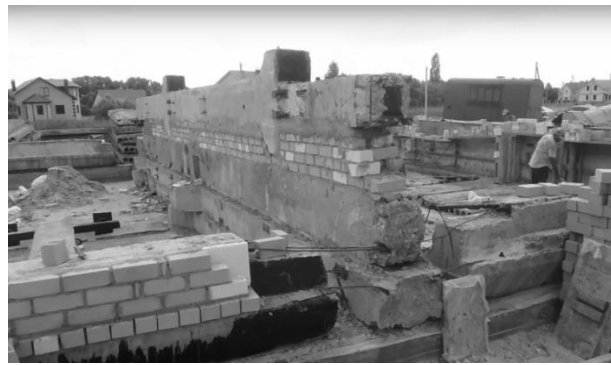
Начало армирования узлов примыкания
