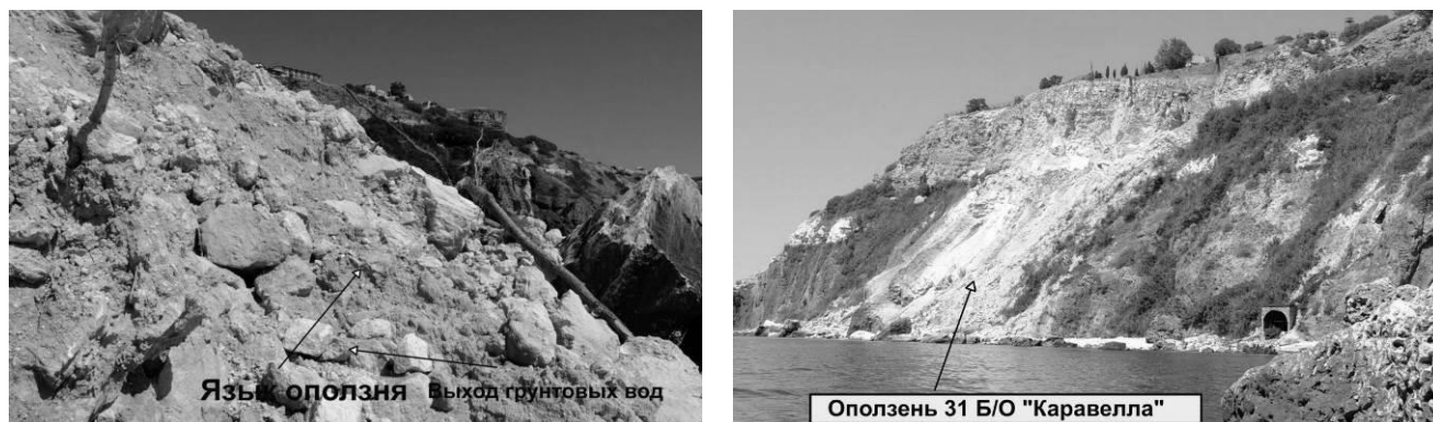
Рис. 2. Выход грунтовых вод в языке оползня 31, слева - общий вид.
