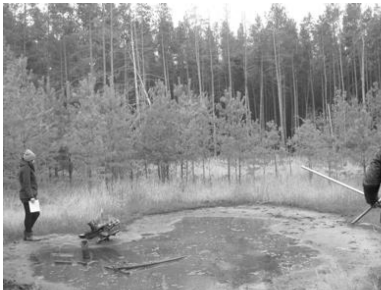
Рис. 1. Излив глубинных вод по затрубному пространству обсадной колонны старой скважины [1].
