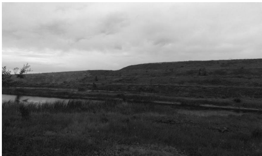
Рис. 2 Террасированный отвал на территории Карбасса.
