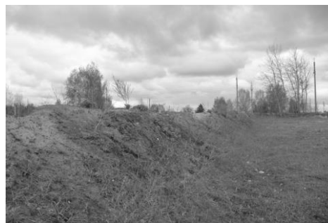
Рис. 3 – Короткие склоны отсыпки автомобильной дороги(западная часть ГРС) Рис. 4 – Короткие крутые склоны вала газопровода в западном районе участка
