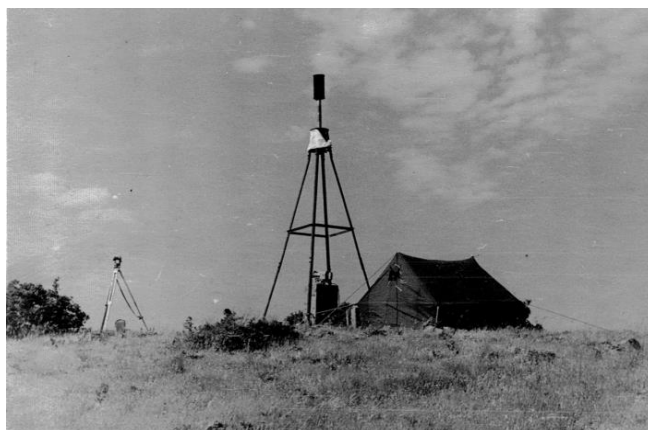
Рисунок 3 – Фрагмент геодезических работ: нивелирования в Ялтинском тоннеле и астрономо-геодезические наблюдения
