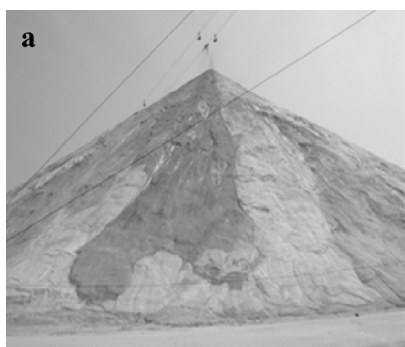
Рисунок 7 – Оползни-сплывы (а) и ручейковая сеть (б) на поверхности отвалов фосфогипса
